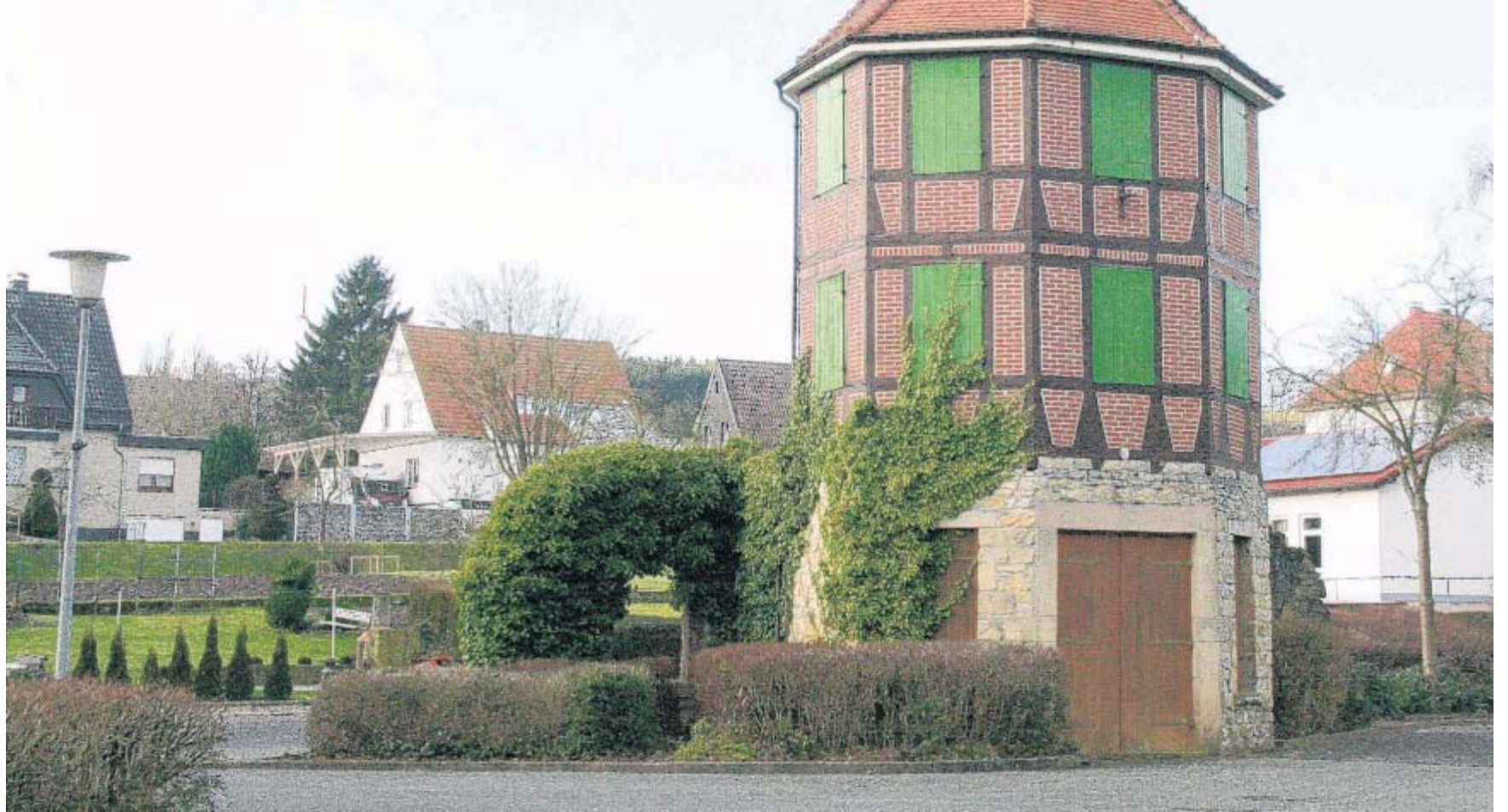
Unter Denkmalschutz: Der Scherfeder Schützenturm wurde im vergangenen Jahr in die Denkmalliste der Stadt aufgenommen.
